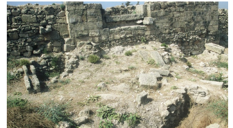
Seuil de porte et canalisations d'évacuation des eaux
